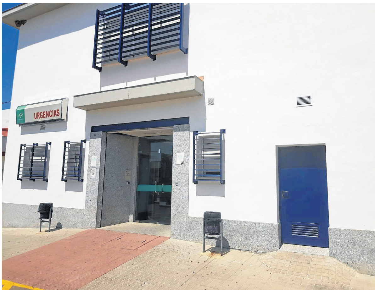
Fachada principal de los servicios de urgencias de Guillena.
