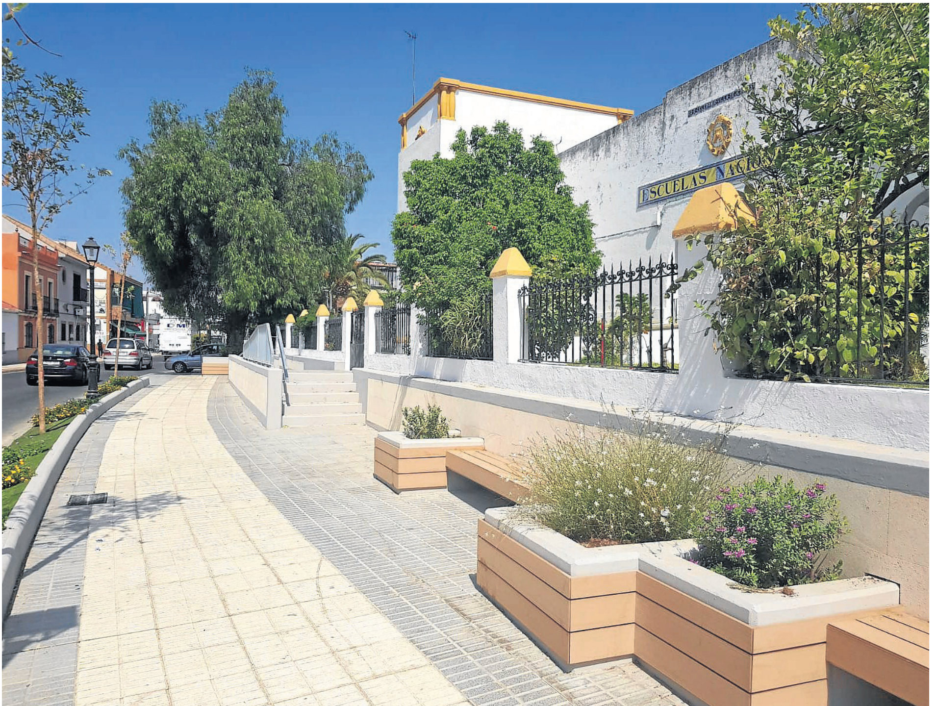
La avenida de Andalucía, una de las calles del municipio de Guillena, que ya se han beneficiado de las inversiones programadas en la vía pública.
